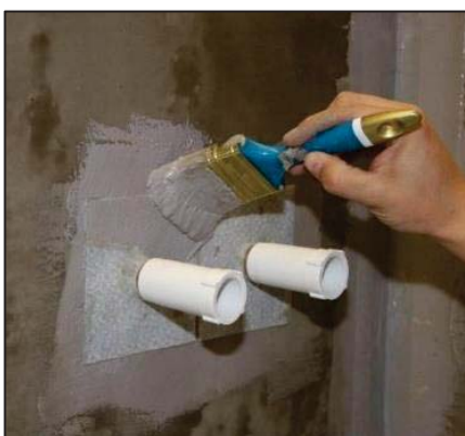
Beispiel zur Abdichtung der Armaturen
