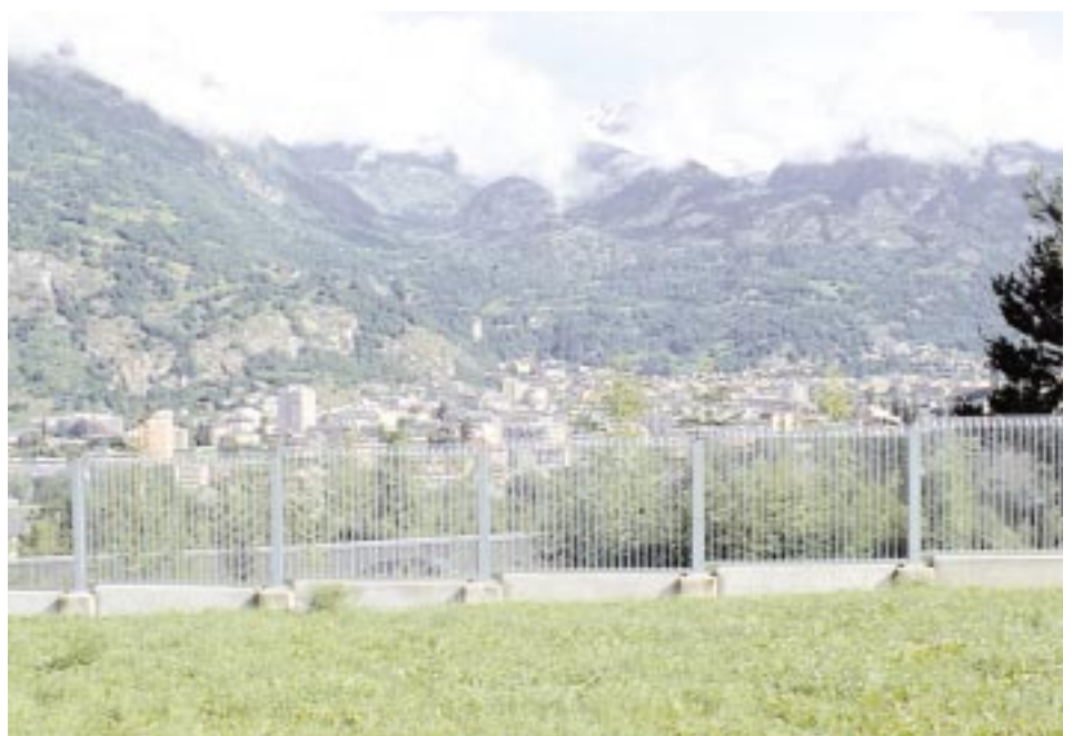
Abb. 1: Übersicht über das Untersuchungsgebiet: Die Schallschutzwand führt zum Teil durch offenes Gelände, zum Teil durch stark mit Hecken, Einzelbüschen und Bäumen durchzogenes Gebiet. Fig. 1: Study area: Transparent walls to minimize noise immissions along motorways lead through open landscape and areas with hedgerows, bushes and trees.
