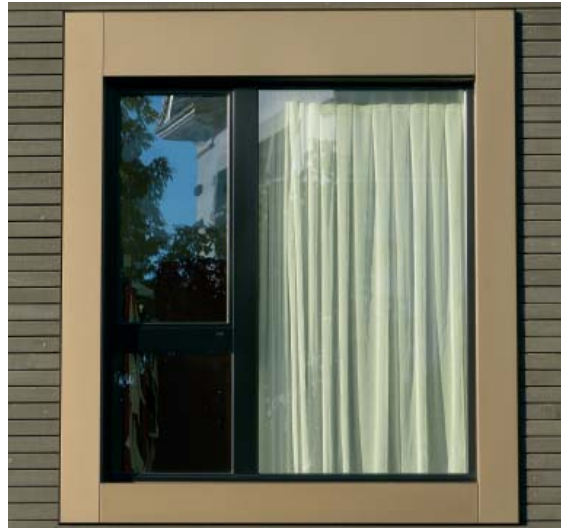
Helle, dicht an den Scheiben anliegende Vorhänge vermögen die Spiegelungen u. U. in frappanter Weise einzudämmen.
