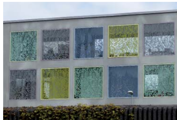
Gut sichtbares Blattmuster auf den Scheiben des Verbindungsganges zwischen Wohnblöcken.
