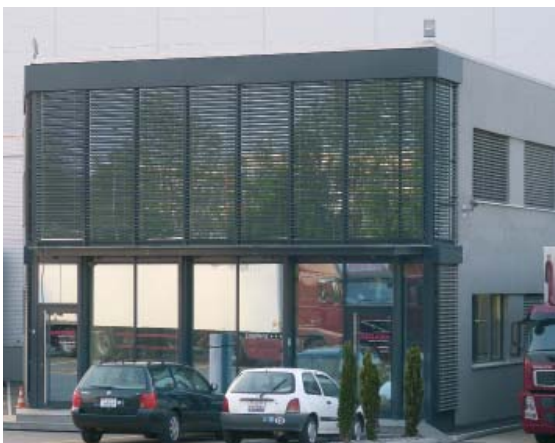
Sonnenschutzglas bei einem Firmeneingang. Durch die Sonnenstoren wird im Obergeschoss die Spiegelung markant gebrochen.
