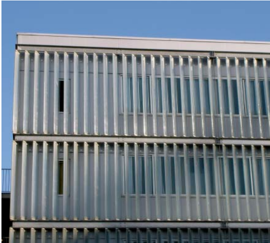
Lisenen («Schwerter») und vertikale oder horizontale Lamellen beschatten und gliedern die Fassade. Wenn so dicht wie in diesem Beispiel angebracht, besteht kaum mehr Gefahr.
