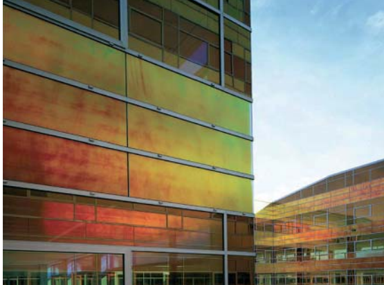
Das stark eingefärbte, reflexionsarme Glas und die nicht-transparenten Ecken machen das Gebäude vogelfreundlich.
