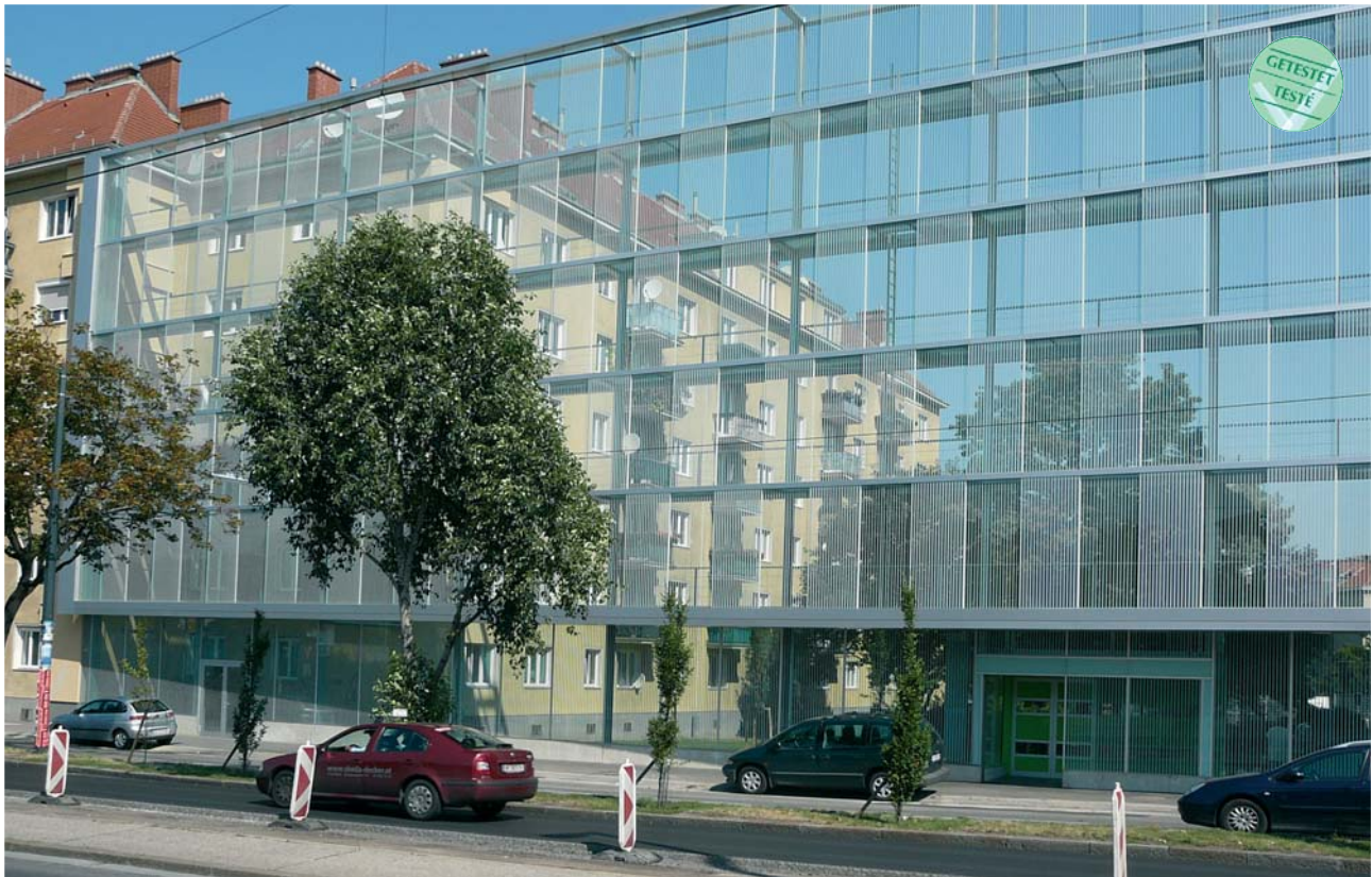
Diese Lärmschutzwand am Theodor-Körner-Hof in Wien wurde 2009 errichtet, um das lärmgeplagte Wohnquartier zu schützen und aufzuwerten. Es ist ein Musterbeispiel für vorbildlichen Vogelschutz, zumal die aufgebrauchten Strukturen zuerst im Flugkanal getestet wurden und dort mit ihrer sehr hohen Erfolgsquote überzeugten.
