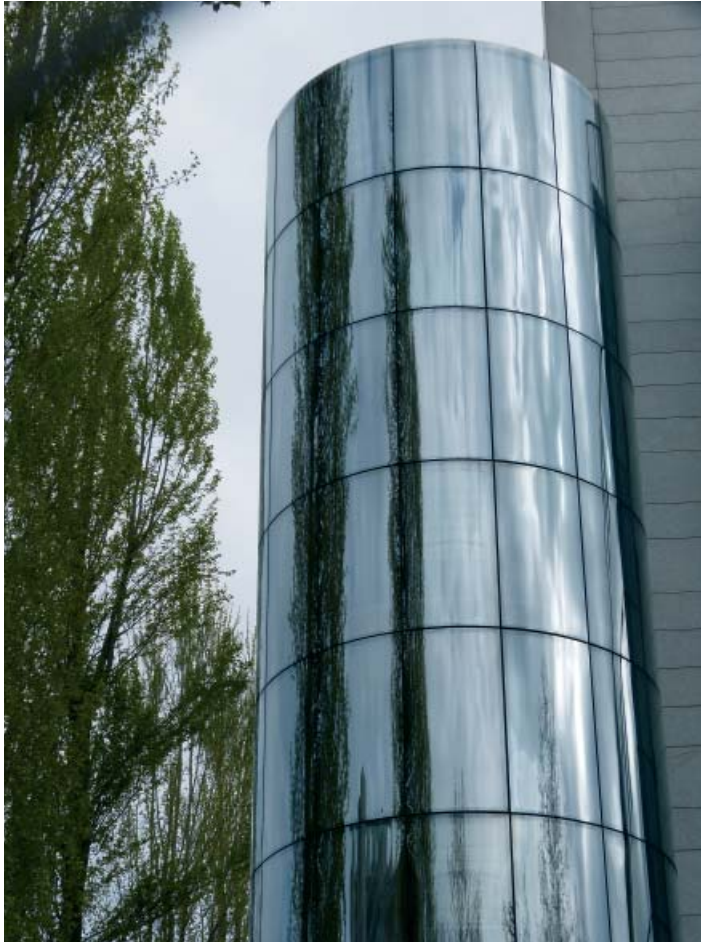
Die Pappeln sind an diesem runden Gebäudeteil nur noch sehr beschränkt als solche wahrnehmbar.
