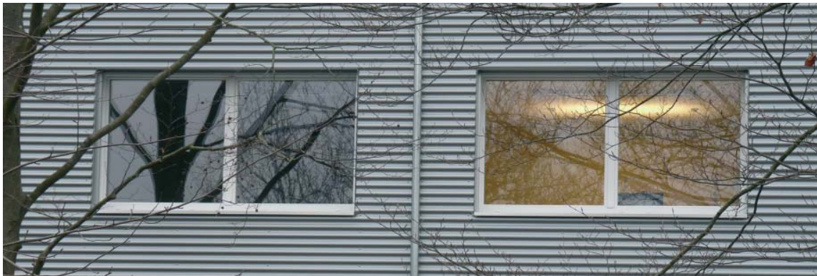
Die Spiegelung hängt von verschiedenen Faktoren ab, so von der Innenbeleuchtung. Derselbe Glastype spiegelt umso stärker, je dunkler der Hintergrund ist.
