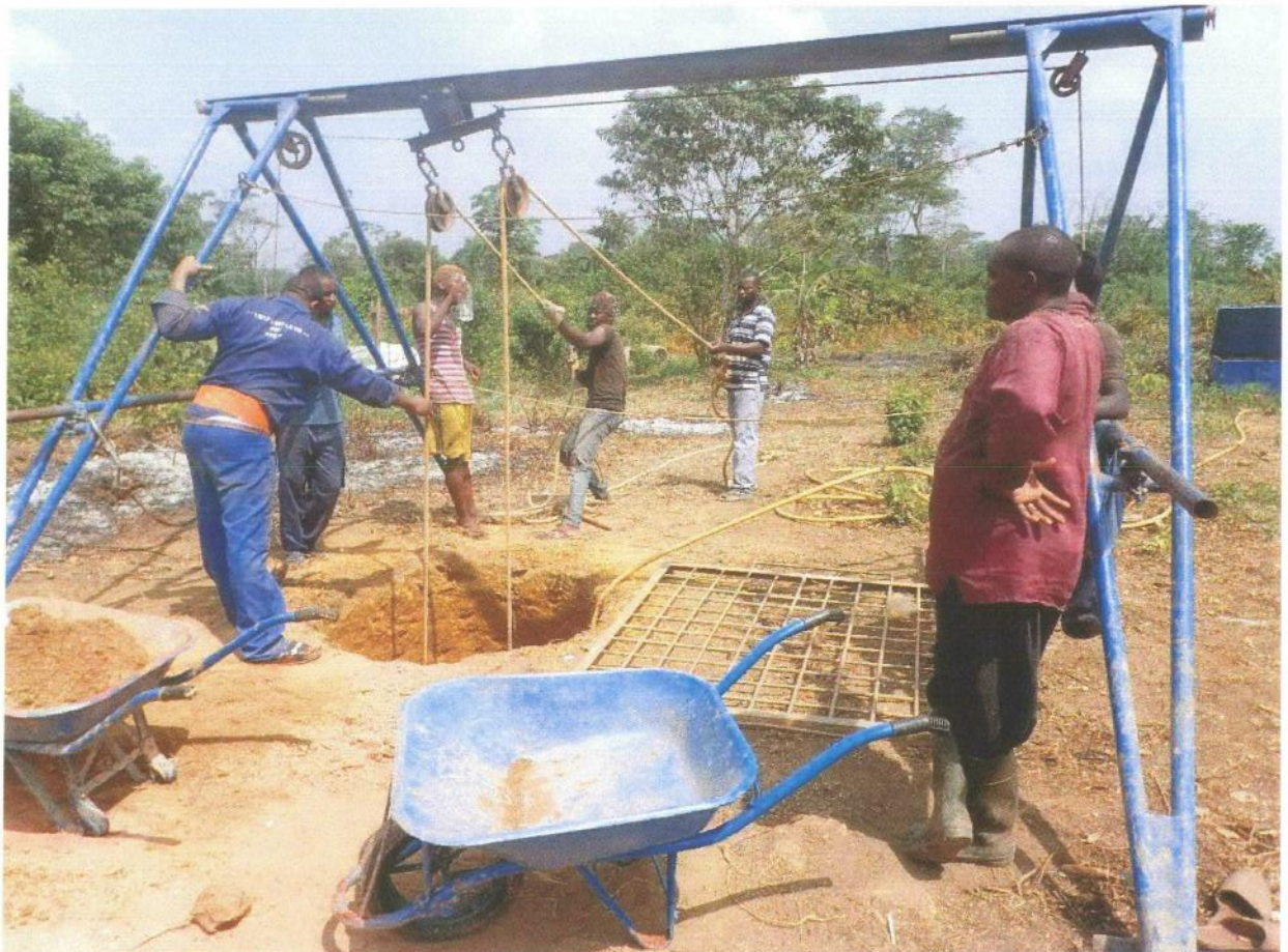
Nach Abschluss der Vorbereitungsarbeiten konnte mit dem Brunnenbau gestartet werden.
